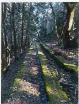
ケーブル線の線路跡。
