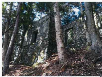
下から見上げると、立派な外壁が確認できます。
